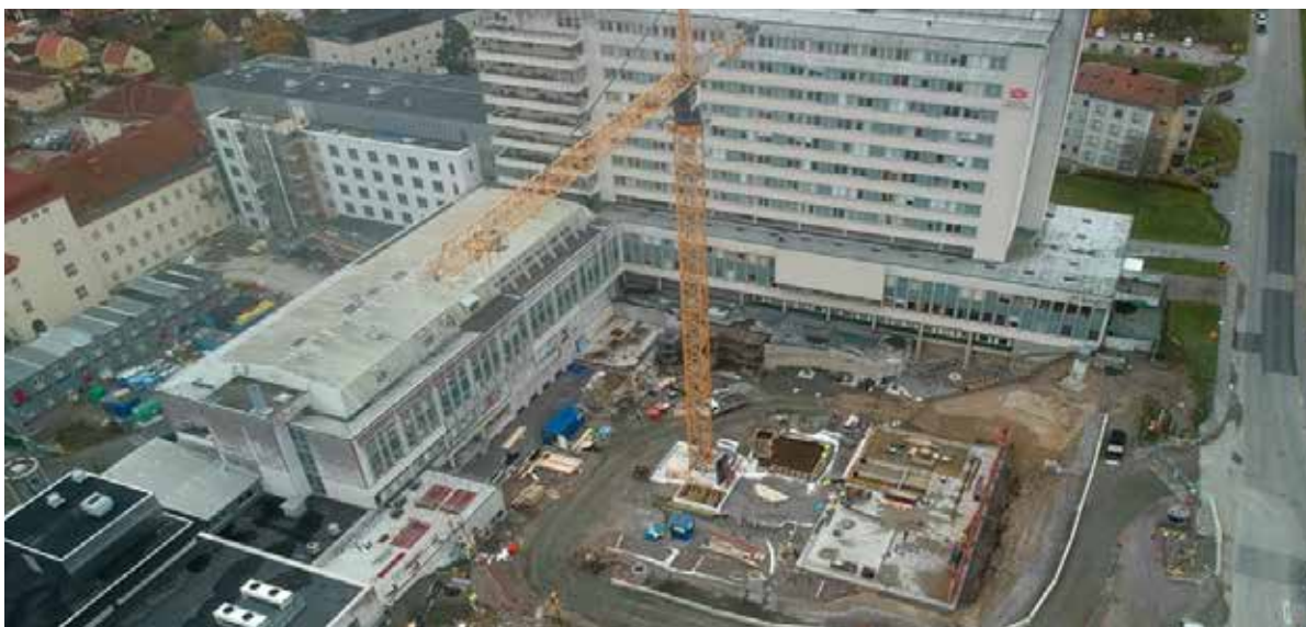
Markarbeten på Nyköpings lasarett
