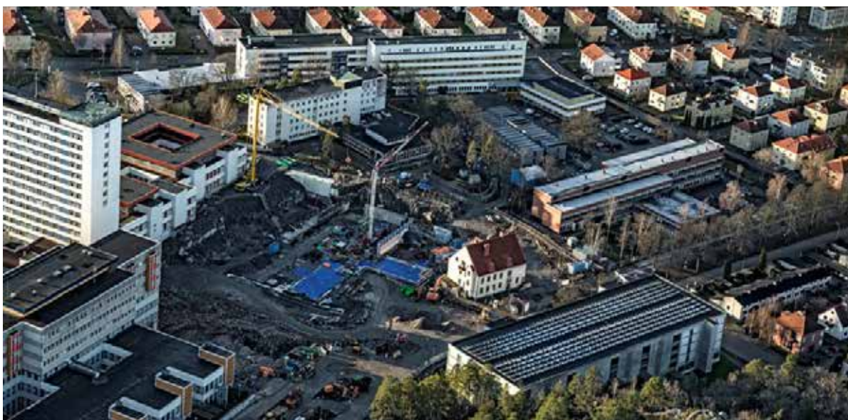
Rivningar vid Mälarsjukhuset i Eskilstuna
