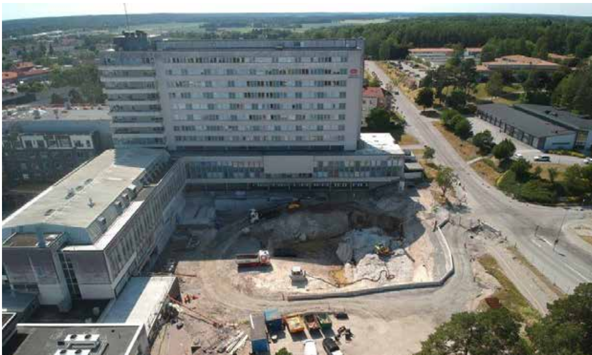
Förberedande markarbeten där nytt akut- och operationshus (N54) ska byggas vid Nyköpings lasarett
