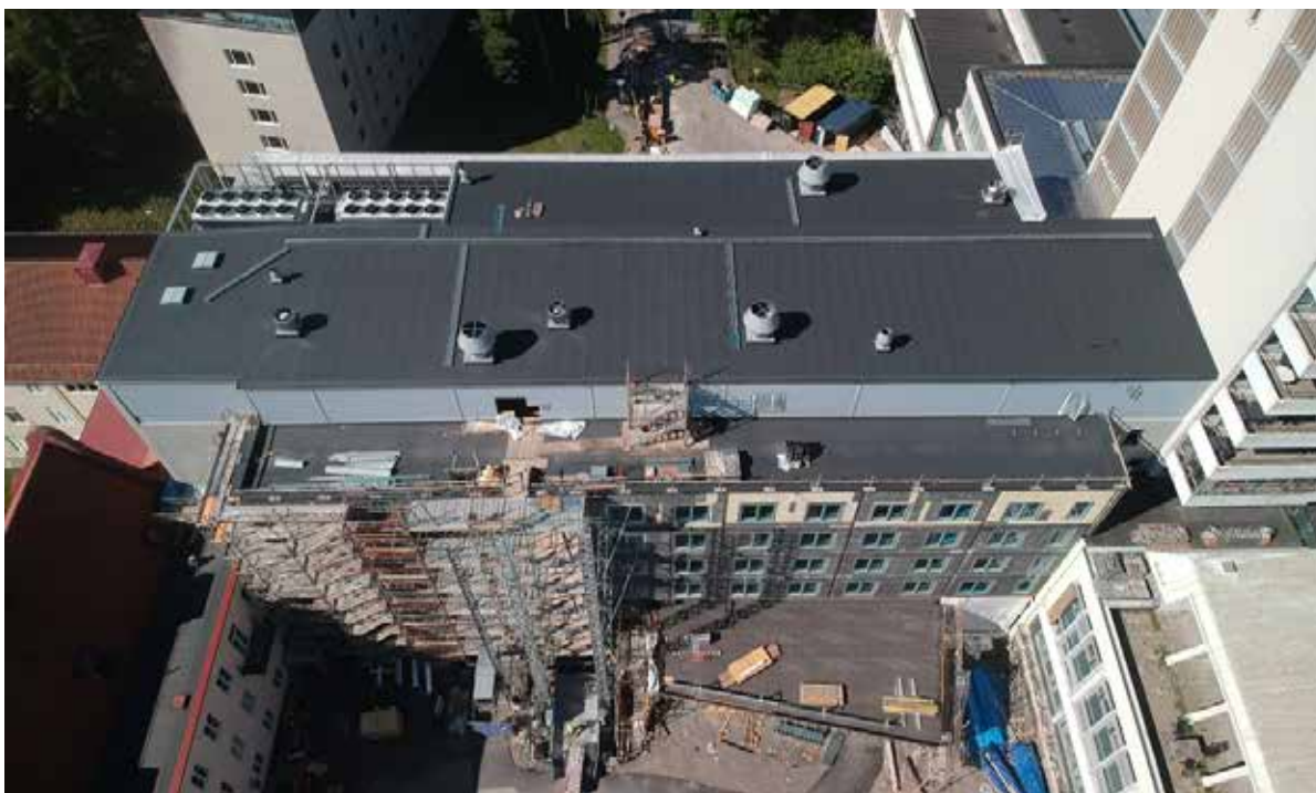
Pågående byggnation av länbyggnad (Hus N55) vid Nyköpings lasarett som bland annat ska innehålla ny huvudentré
