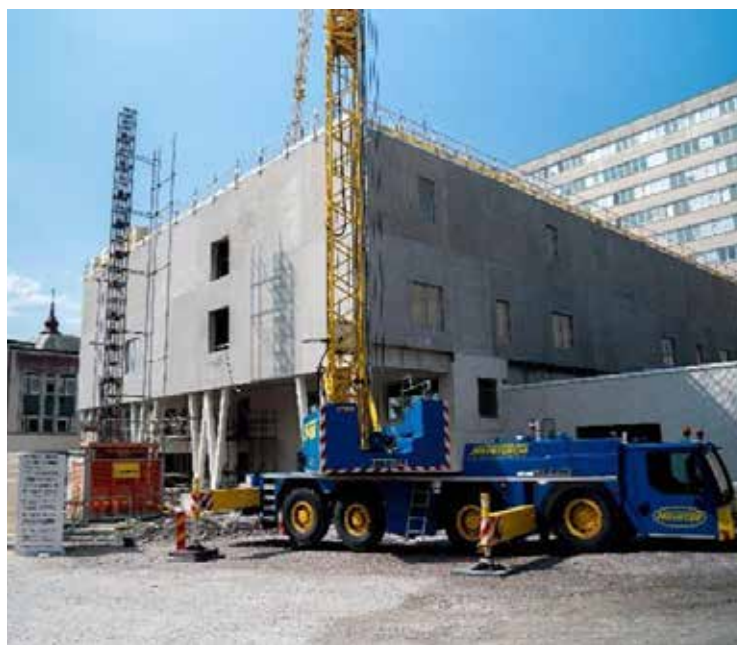
Nyköpings lasarett, hus N54. På bilden ser vi det nya akut-och operationshuset som beräknas stå byggklart i slutet 2022
