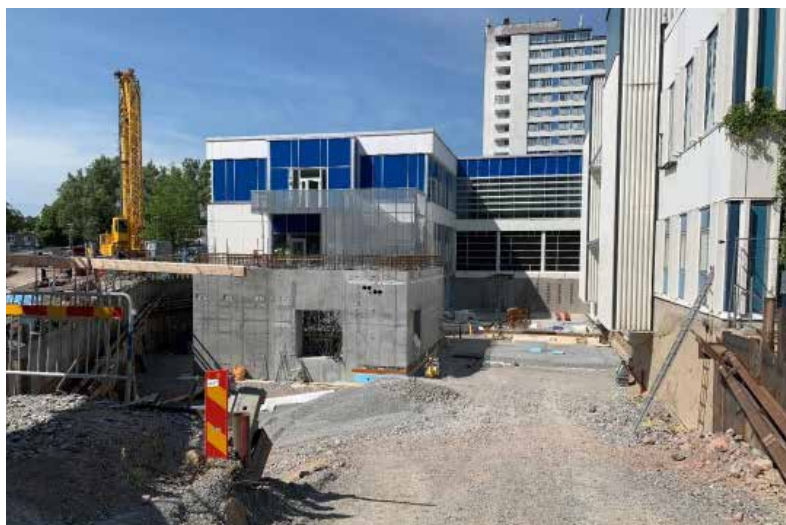
Pågående byggnation av ny strålbunker på Mälarsjukhuset. Beslut om nybyggnation fattades av regionstyrelsen i oktober 2019 med komplettering i november 2020.
