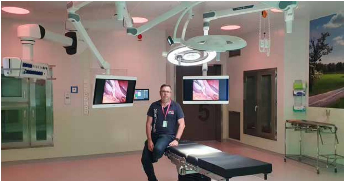
Operationssal med grönt och rött ljus vilket är en ergonomisk belysning för personalen vid operationer. Belysningen används vid bildskärmskirurgi exempelvis tithålskirurgi. På bild är Patrik Karlsson, narkossjuksköterska och projektledare för operationsverksamheten på Nyköpings lasarett
